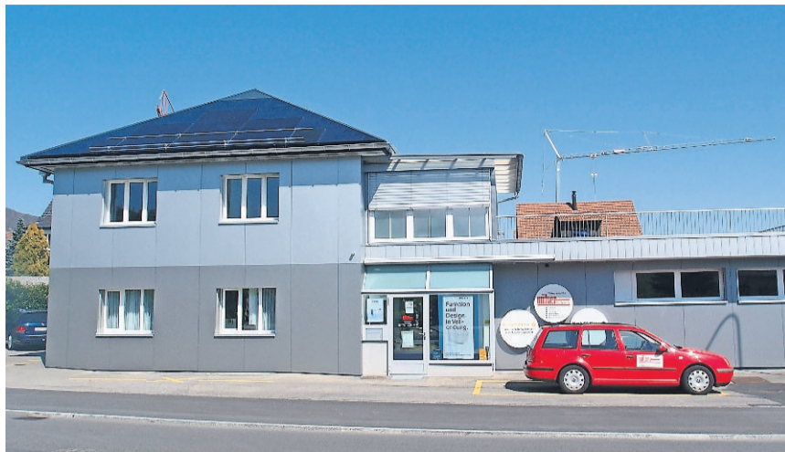
Die umfassende Modernisierung des Firmengebäudes der Wülser Lostorf AG mit Photovoltaik-System sorgt für beste Eigenwerbung. (Bild: ZVG)
