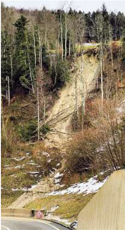
Nach dem Rutschereignis auf der gereinigten und provisorisch gesicherten Passwangstrasse. ZVG
