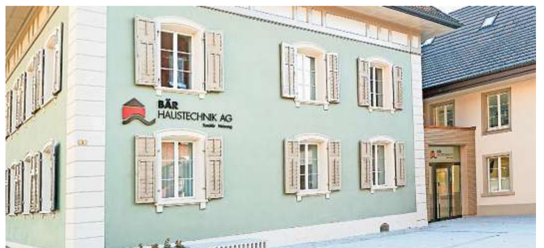
Die stilvoll renovierten Geschäftsräume der Bär Haustechnik an der Aarburger Sägestrasse.
